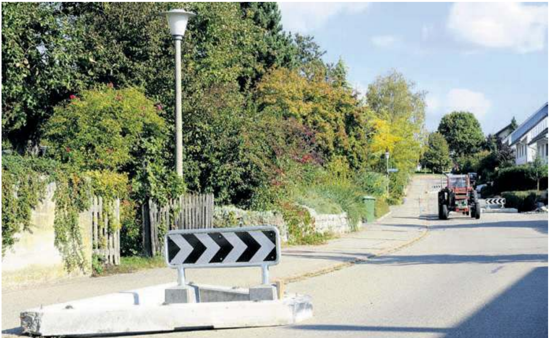
Im Hinblick auf die Erstellung des verkehrstechnischen Gutachtens liess der Gemeinderat im letzten Herbst sogenannte Nasen anbringen. Sie sind heute wieder entfernt. Bild: hd
